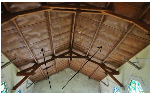
panneaux bois-isorel (?) sous chevrons
