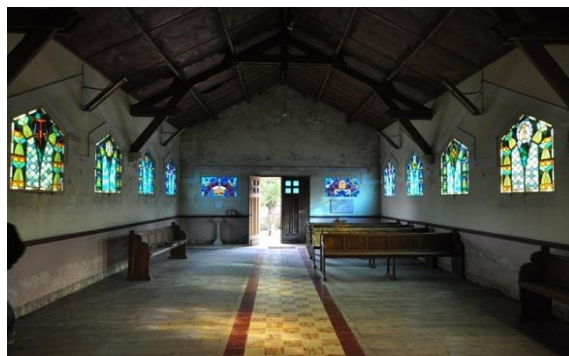
fermes à entrait retroussé et jambes de force et blochet
